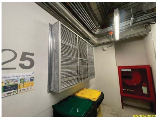
ระบบระบายอากาศโถงลิฟต์
